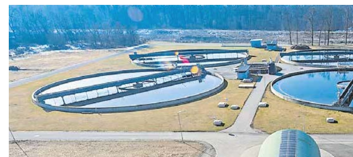
Klärschlamm wird zur Energiegewinnung genutzt. Ein Vorzeigeprojekt von Holding Graz, Stadt Graz und Verbund.
