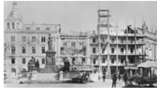
Bauarbeiten am dritten Rathaus, Foto aus dem Jahr 1892.
