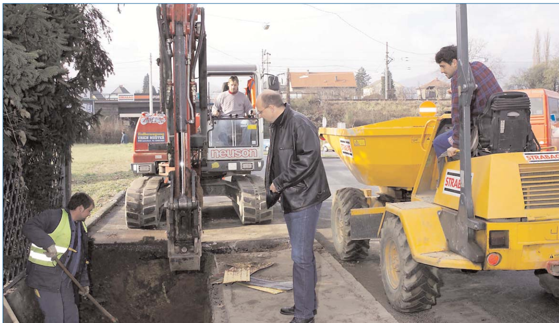
Die Sanierungs- und Erweiterungsarbeiten an der Infrastruktur unserer Stadt werden von Helmut Spanner (Bild Mitte) koordiniert.
